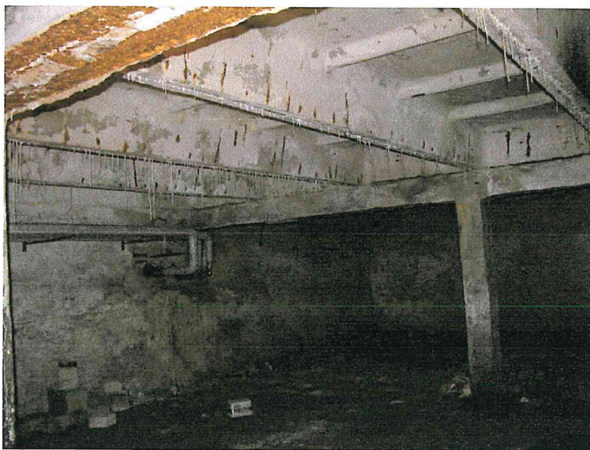
Zdj. Nr 1 Wymyte z betonu (na styku płyt panwiowych) związki chemiczne są potwierdzeniem znacznej korozji betonu.
