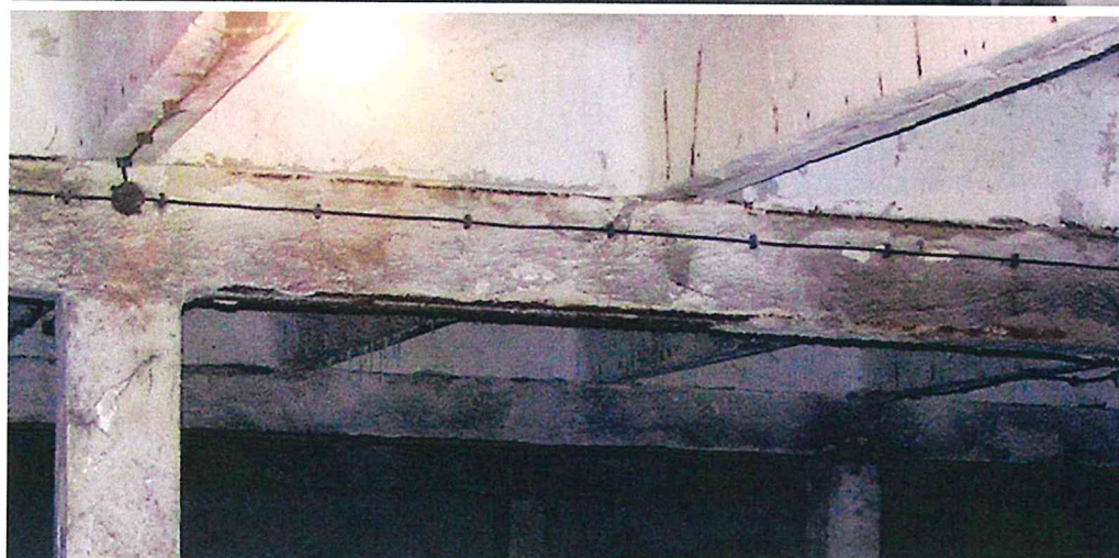
Widoczne „sople” i korozja podciągów
