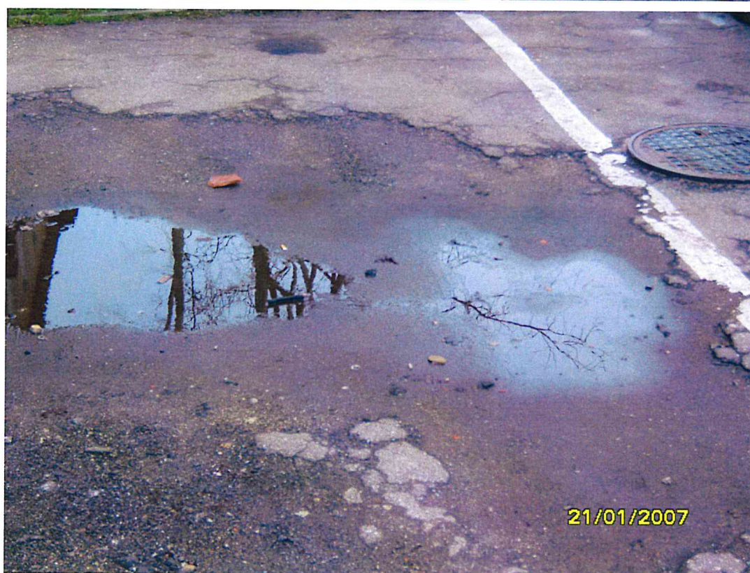
Widoczne ubytki nawierzchni asfaltowej
