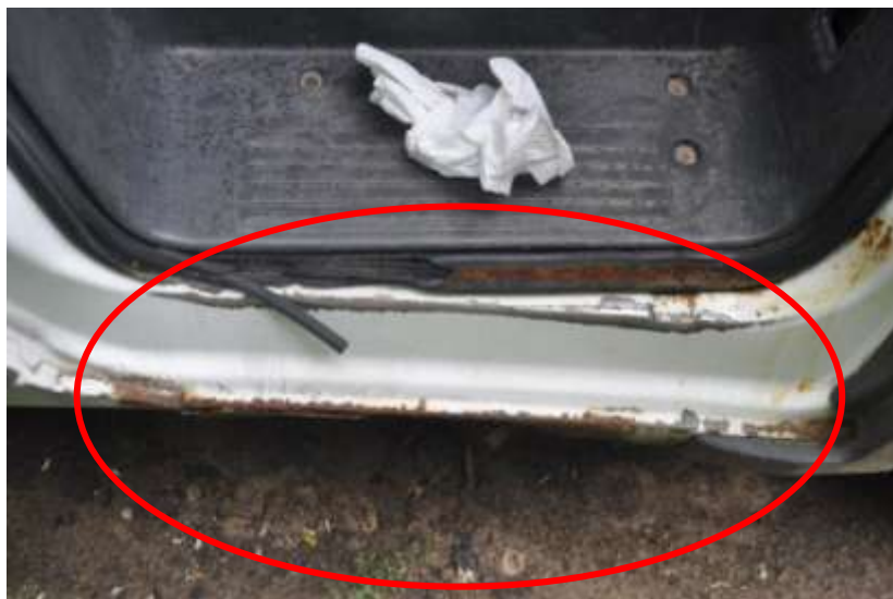
Fot. nr 11. Badania pojazdu – zakres uszkodzeń.
